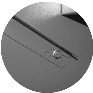
Установленные стяжки на левой боковой стойке
